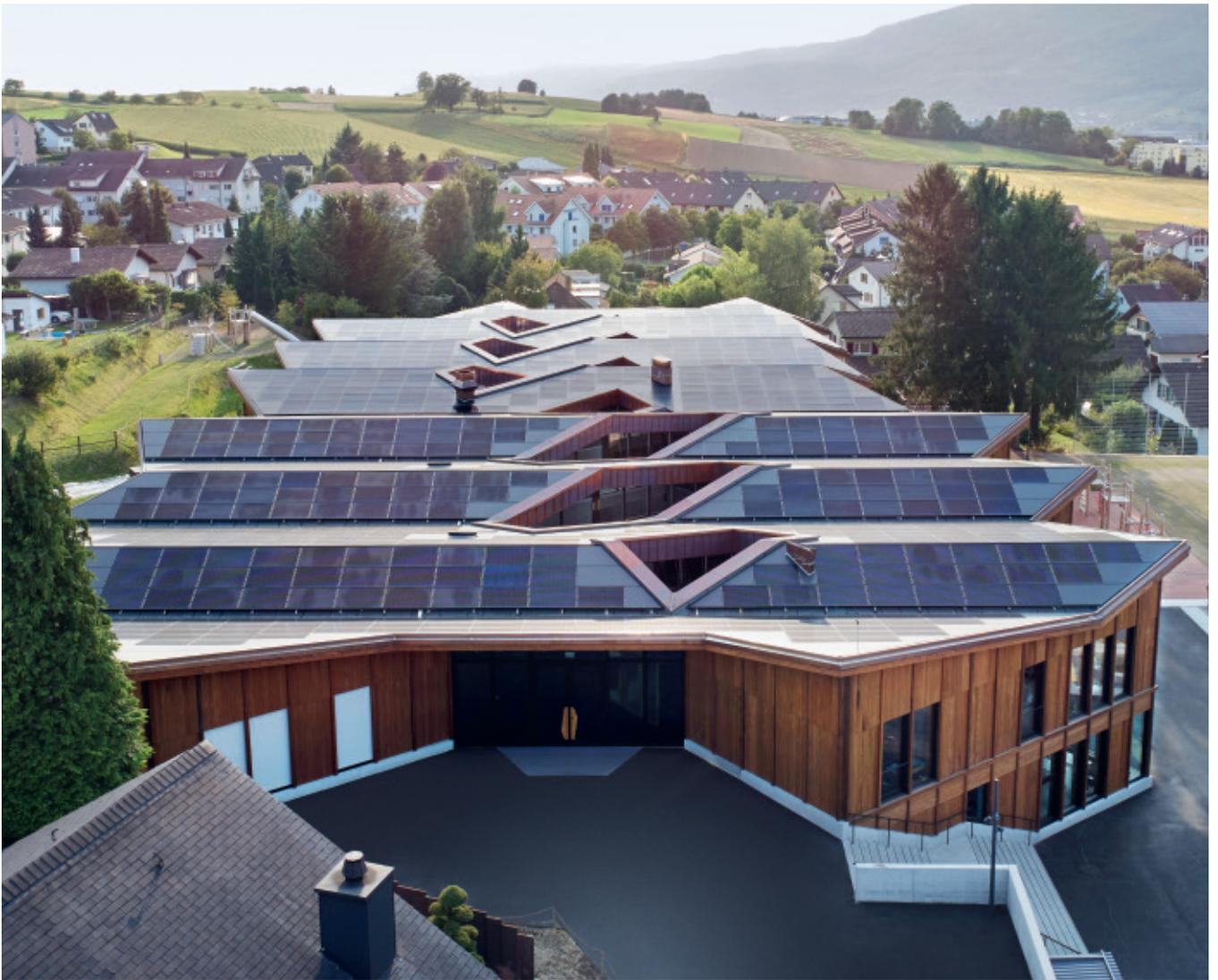
**Primarschule Port:** Das gefaltete Dach ist Teil des architektonischen Ausdrucks des weitgehend vorgefertigten Holzelementbaus. Die in die 1800 m<sup>2</sup> grosse Dachfläche integrierten Fotovoltaik-Paneele produzieren einen Stromüberschuss, der dem Jahresverbrauch von rund 50 Haushalten entspricht. Architektur: Skop GmbH, Zürich. Foto: Julien Lanoo
